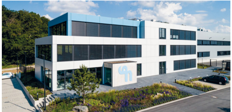
Der neue Firmensitz von Schuchmann wurde 2020 bezogen.
