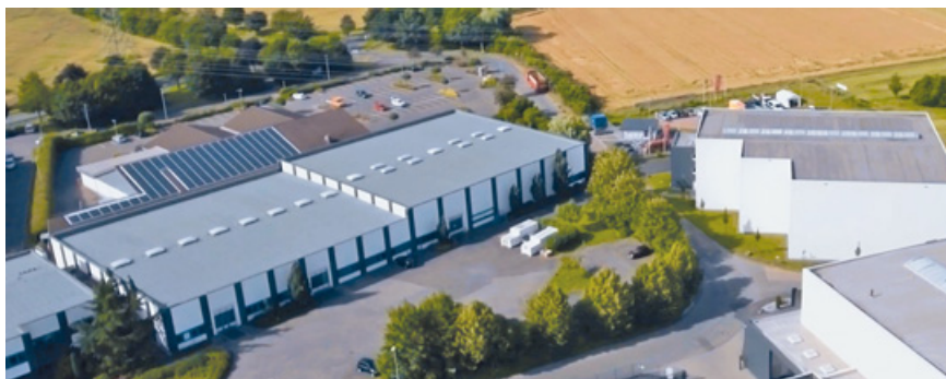
Der Firmen-Komplex mit Kommissionier- und Paletten- sowie Hochregallager.
