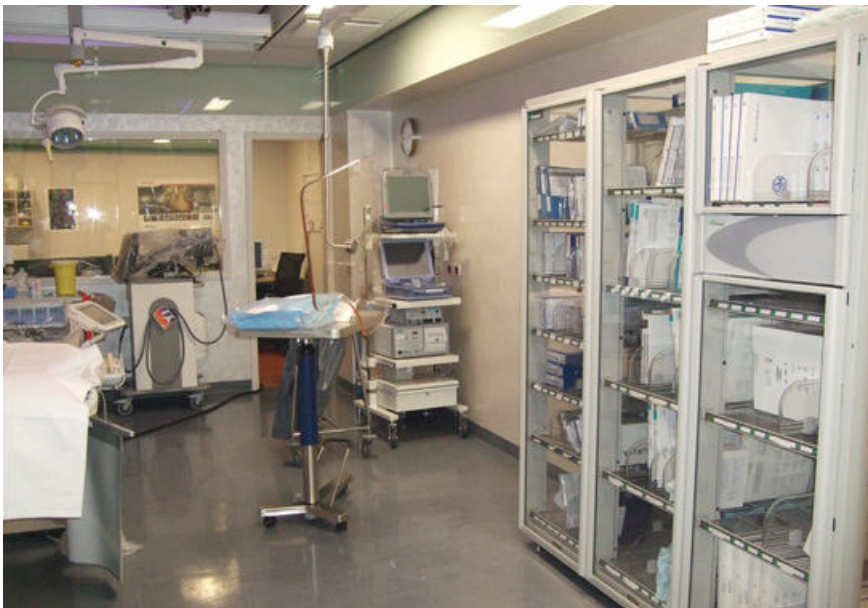
Abb. 2: EVS-Versorgung im Katheterlabor des OLVG-Krankenhauses, Amsterdam.
